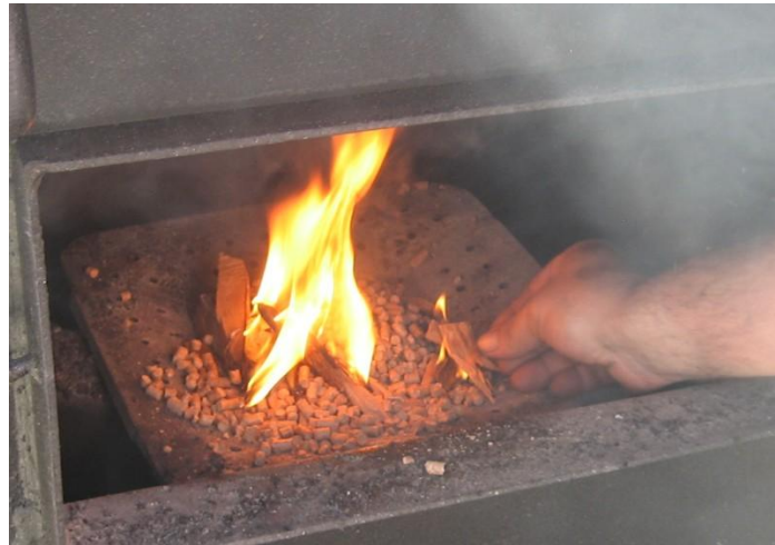
Рисунок 7 – Ручной розжиг топлива в котлах версии RK3G/S
