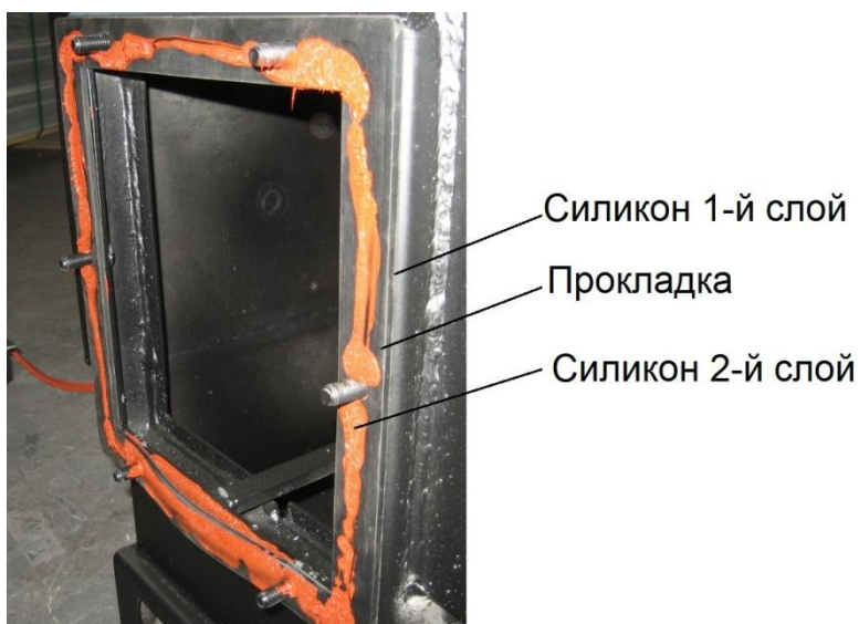
Рисунок 16 – Установка прокладки на силикон и нанесение второго слоя.
