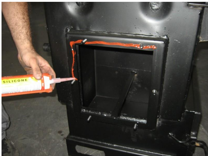
Рисунок 15 – Нанесение жаростойкого силикона перед установкой прокладки.
