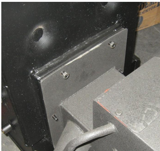
Рисунок 17 – Установленный на котле корпус шнековой подачи.
